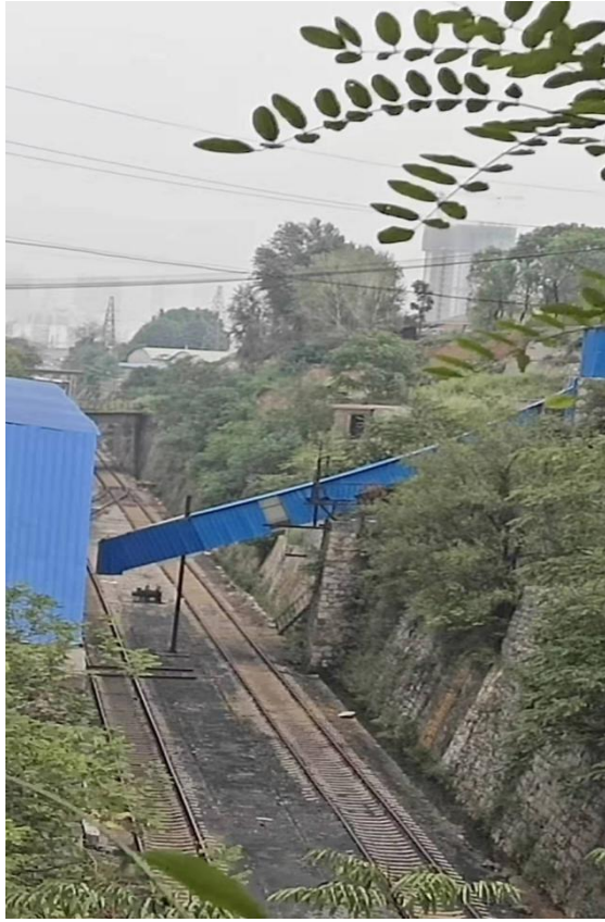
封闭输煤廊道
