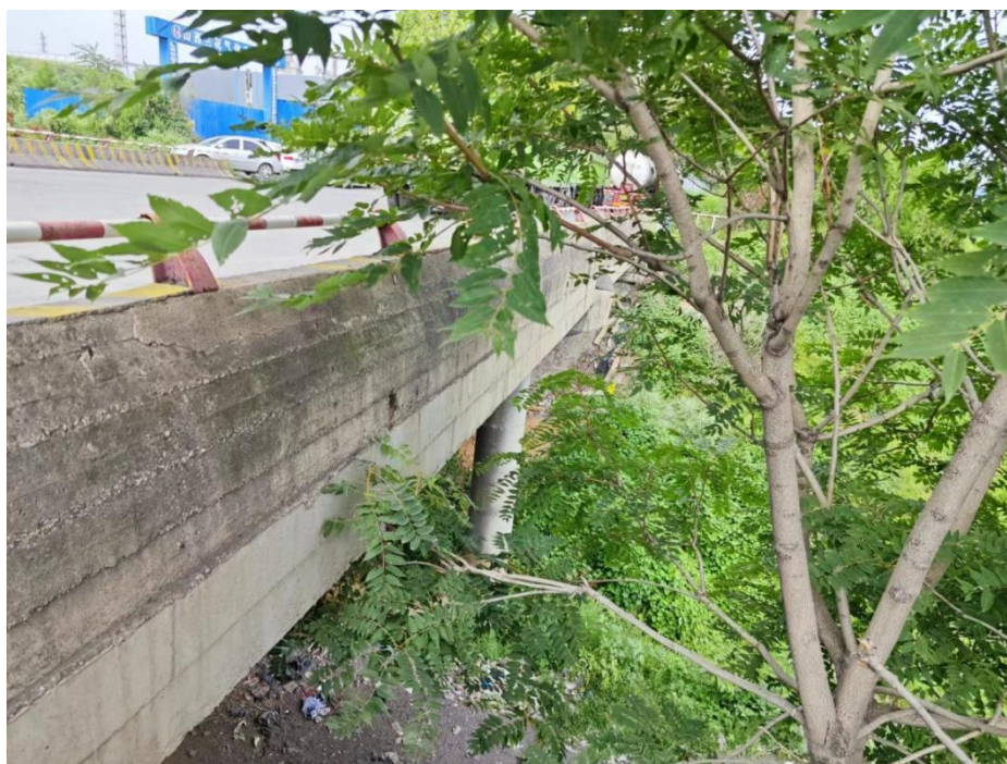
图 2.4-1 兰花煤化工桥
