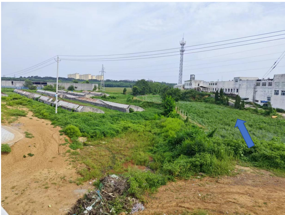
图 2.2-3 华达街桥下游河道现状
