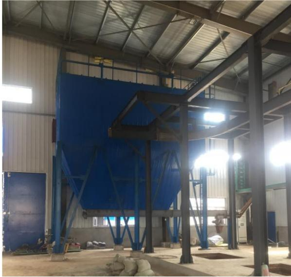
原料破碎工段布袋除尘器
