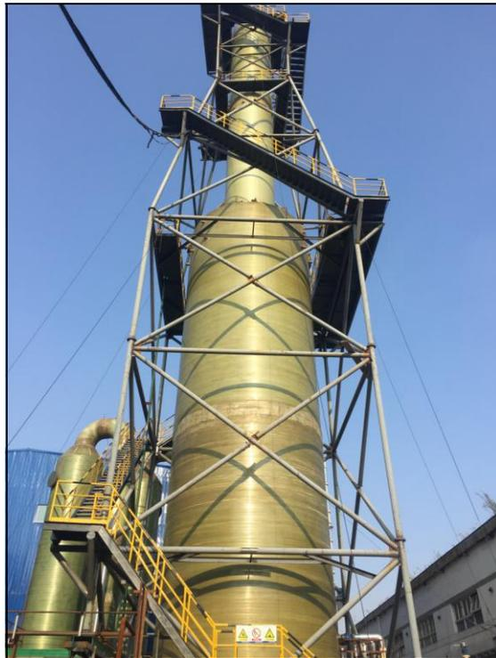
洗涤塔+排气筒（排气筒高度40m，内径2.5m）
